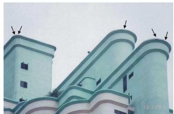
b) Nahaufnahme: Die schwarzen Pfeile zeigen auf die „Bypass-Schäden“ (innerhalb des vom Hersteller angegebenen Schutzraums)
