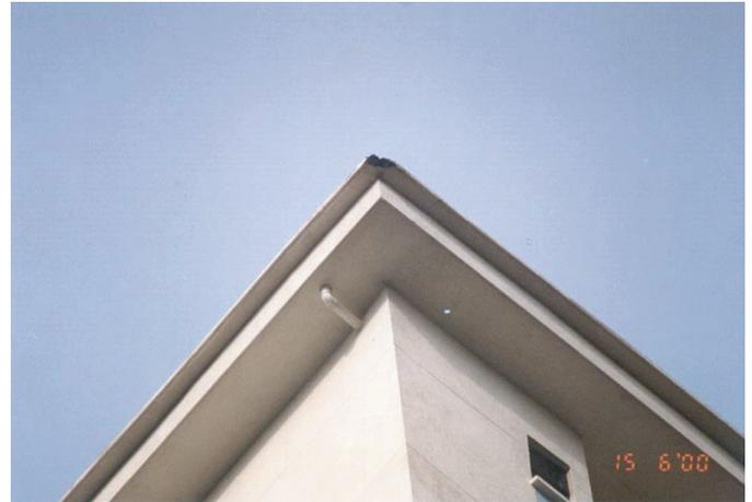
**Bild 7.** „Bypass-Schäden“ (Pfeil) dicht unterhalb des ESE-Geräts Dynasphere [17]
